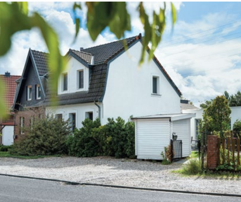
In diesem Gebäude in Krefeld wurde von Buderus ein hybrides Heizsystem installiert.
